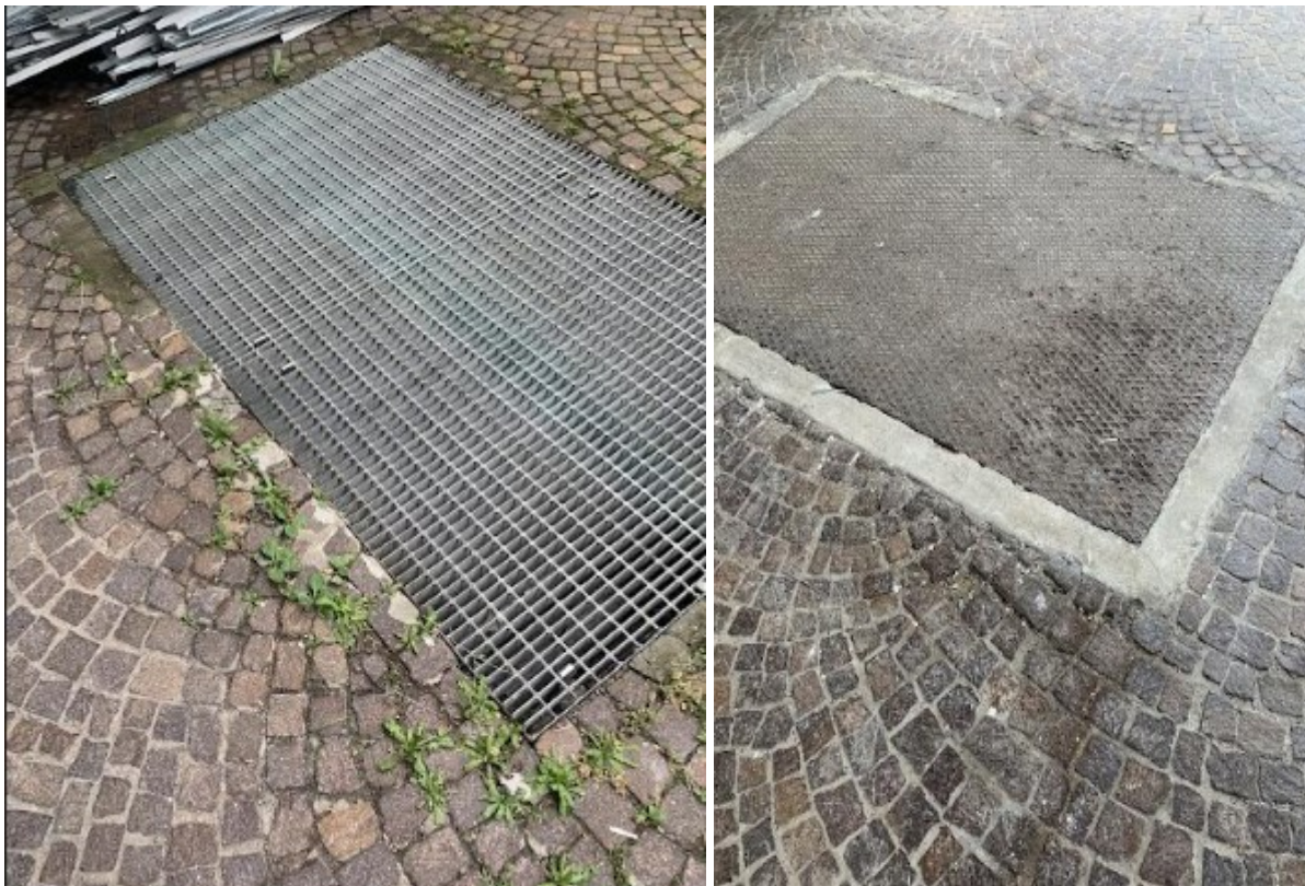
Nuova Pavimentazione esterna Piano Terzo e Terrazzo adiacente
